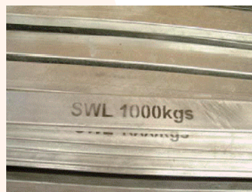
安全承重量已标注在每条梁上
